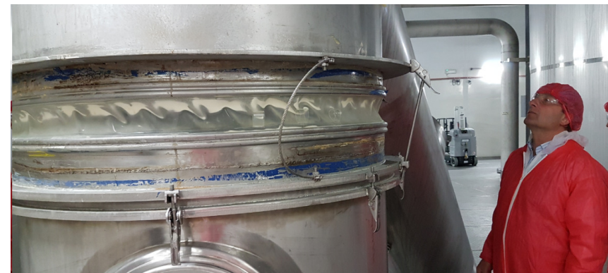
Under silo 1600mm \varnothing , nedanför konisk 200 \rightarrow 250mm Mjölkpulver-sikt
