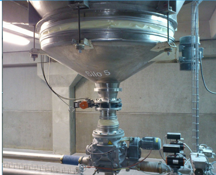
Under silo 1600mm \varnothing , nedanför konisk 200 \rightarrow 250mm Mjölkpulver-sikt
